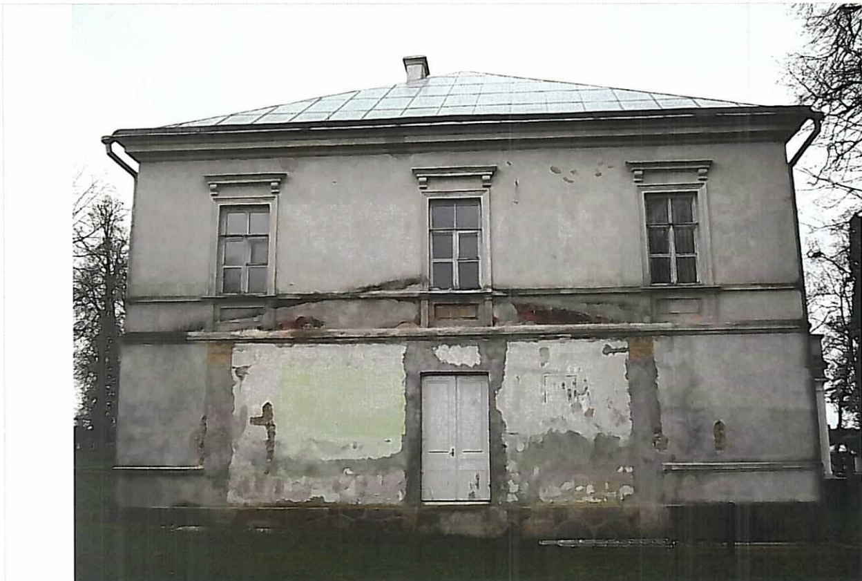
7 pav. Šiaurinio fasado, esančio tarp ašių D-A, vaizdas.
