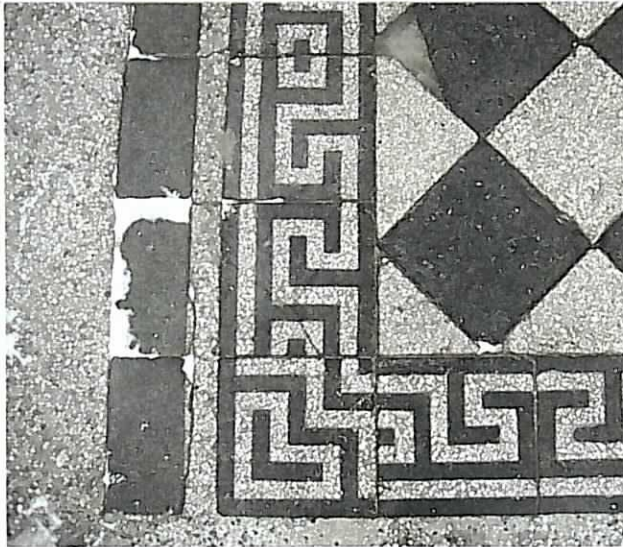
14 pav. Teraco plytelių danga išorės laiptų aikštelėje.
